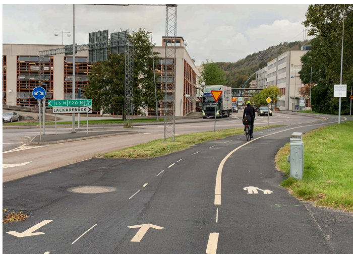
Foto: ny beläggning längs Flöjelbergsgatan.
