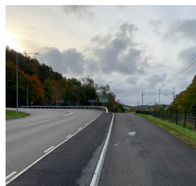
Foto: avåkningsräcke på Kungsbackavägen.
