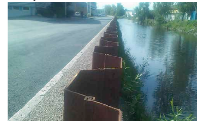
Invallning av norra Ågatan i centrala Mölndal efter utförd muddring 2007/08.
