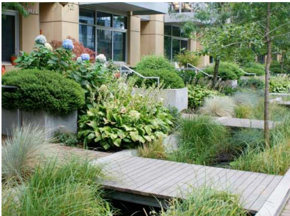
Figur 12. Kanalen avvattnar och avleder dagvatten från bostadsområdet. Anlagda gångbroar förbinder kvartersmarken med den allmänna. (Huddinge kommun, 2014)
