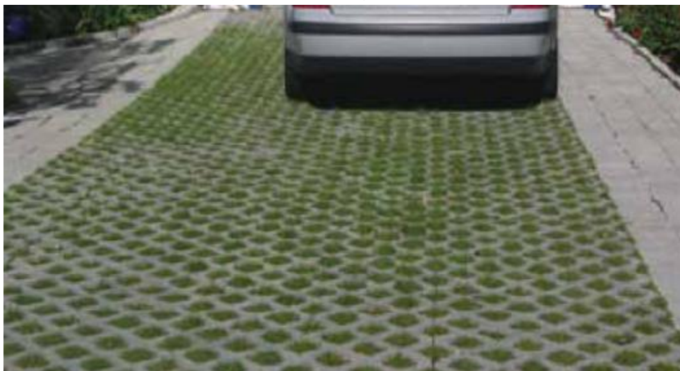
Figur 10. Genomsläpplig rasterbeläggning på parkeringsplats. (Uppsala vatten, 2014)
