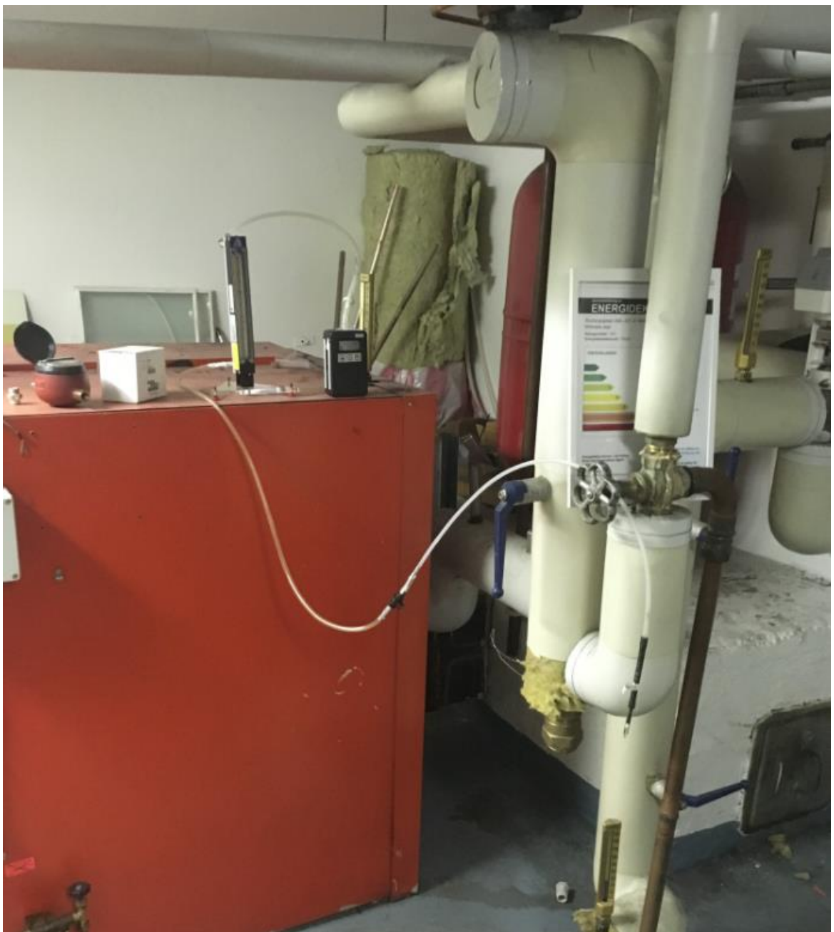
Figur 6. Översiktsfoto över provtagningspunkt GAS10 (#6798745289) inne i pannrummet.
