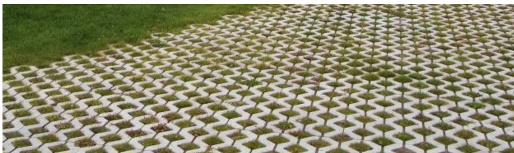
Figur 19 Exempel genomsläpplig beläggning med gräsarmering (Foto: St Eriks)
