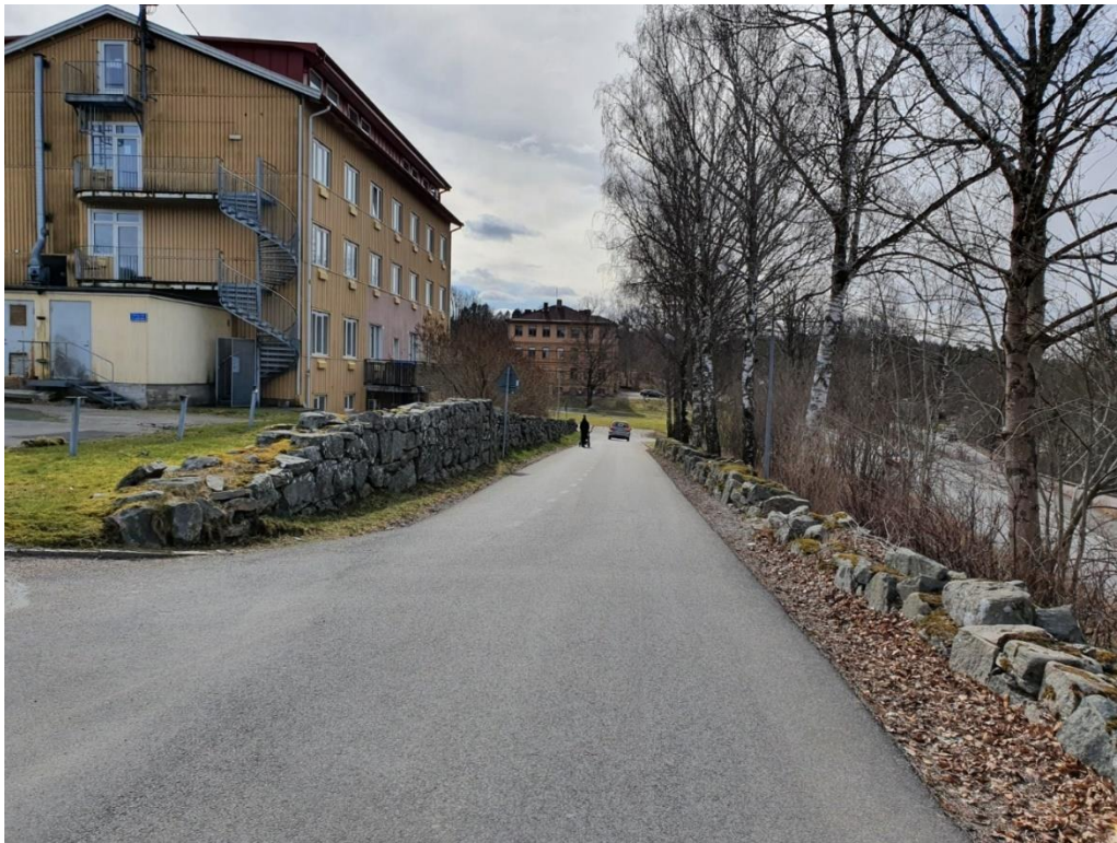
Figur 7 Stenmuren längs stenmursvägen framför fastighet 1:192.
