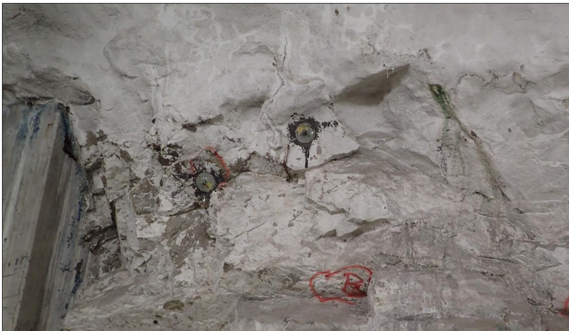
Figur 4-6 Foto av sydvästra anfanget i huvudentrén som visar selektiv bultförstärkning av mindre, instabila block.
